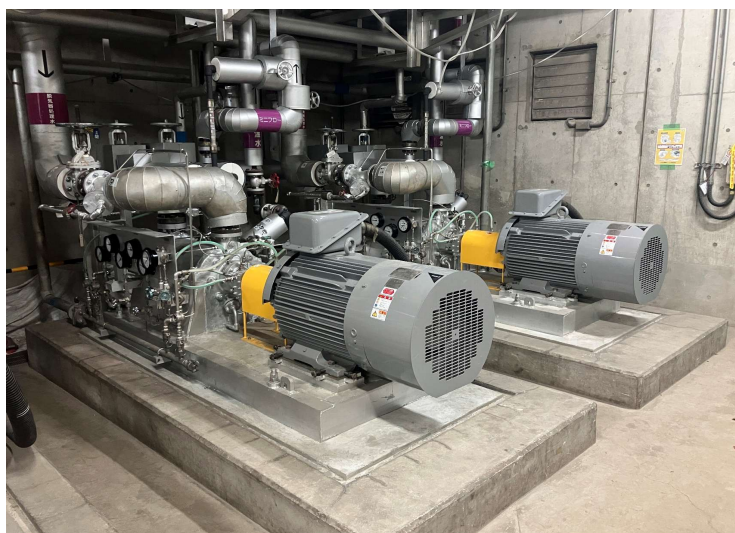
ボイラ給水ポンプ据付後
