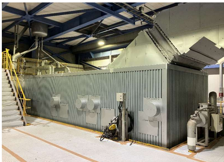
ボイラ据付後
