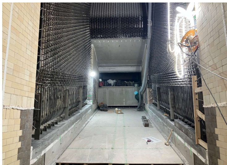
耐火物工事施工中
