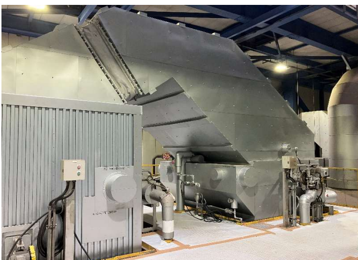
煙道及び節炭器据付後
