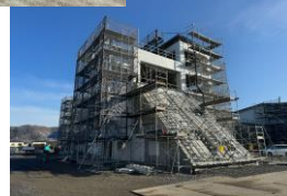
独立訓練塔 山岳壁工事
