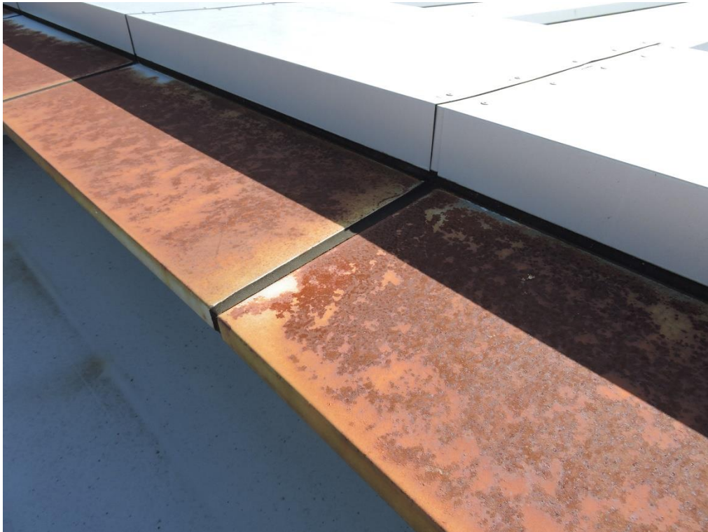
笠木ジョイント目地部分シーリング工事（一部抜粋）
