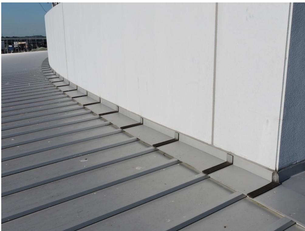
板金ジョイント目地部分シーリング工事（一部抜粋）
