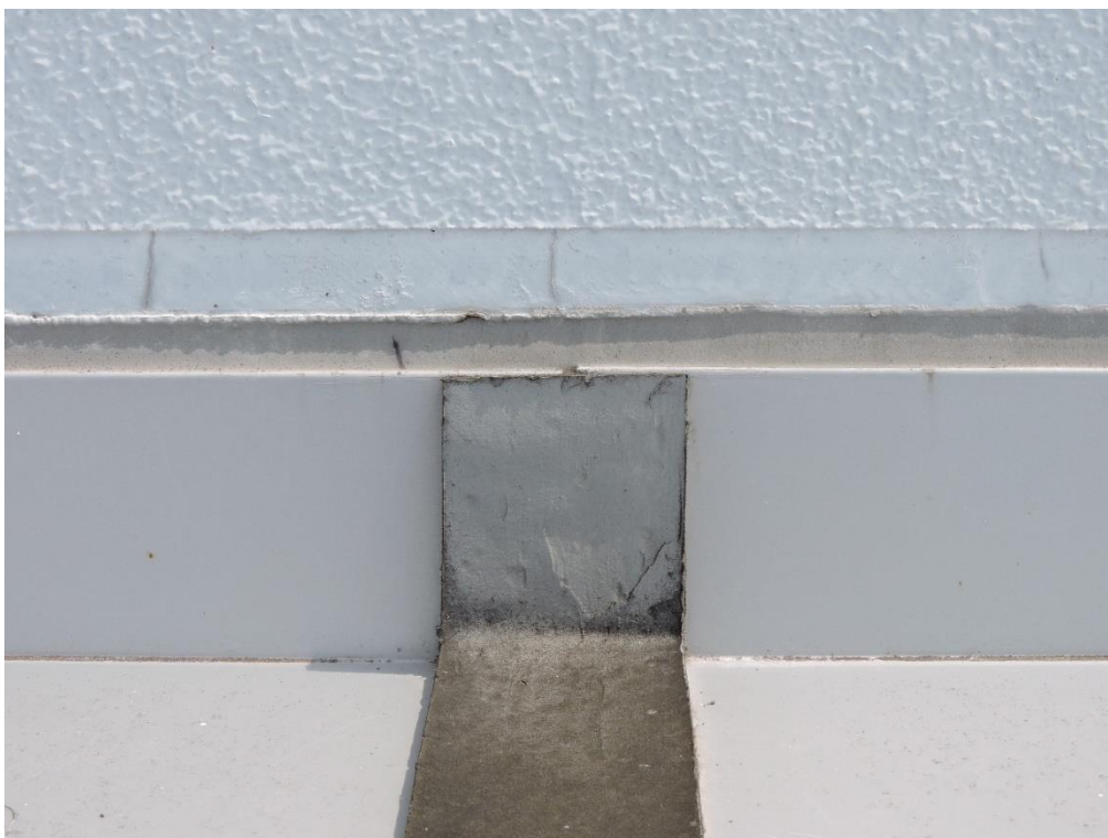
板金取合部分シーリング工事（一部抜粋）
