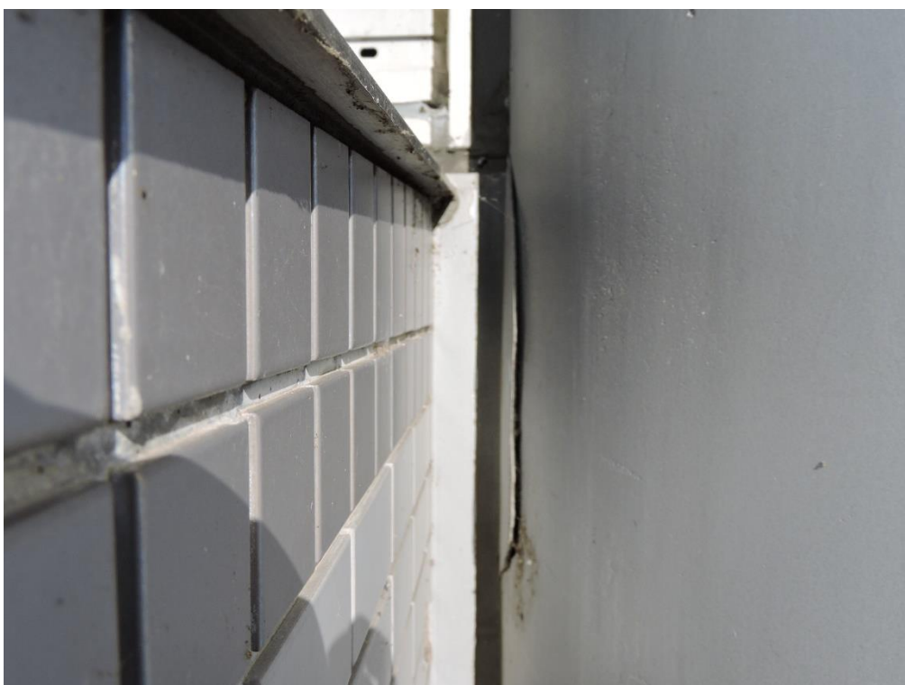
タイル取合目地部分シーリング工事（一部抜粋）
