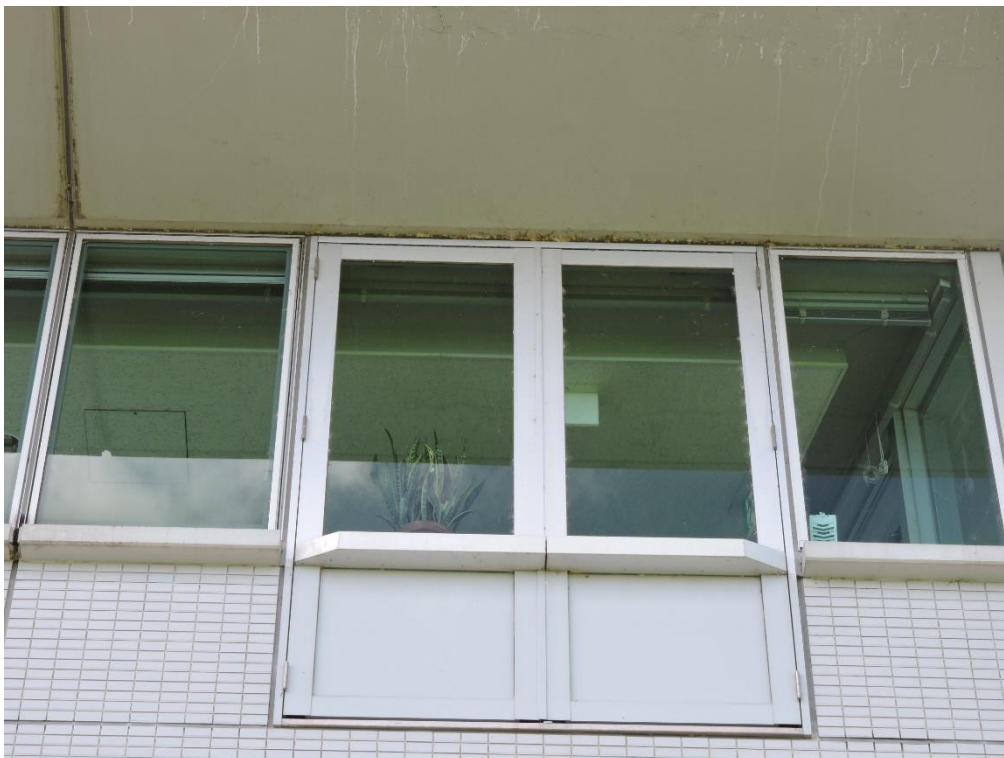
サッシ廻り・サッシ目地部分シーリング工事（一部抜粋）
