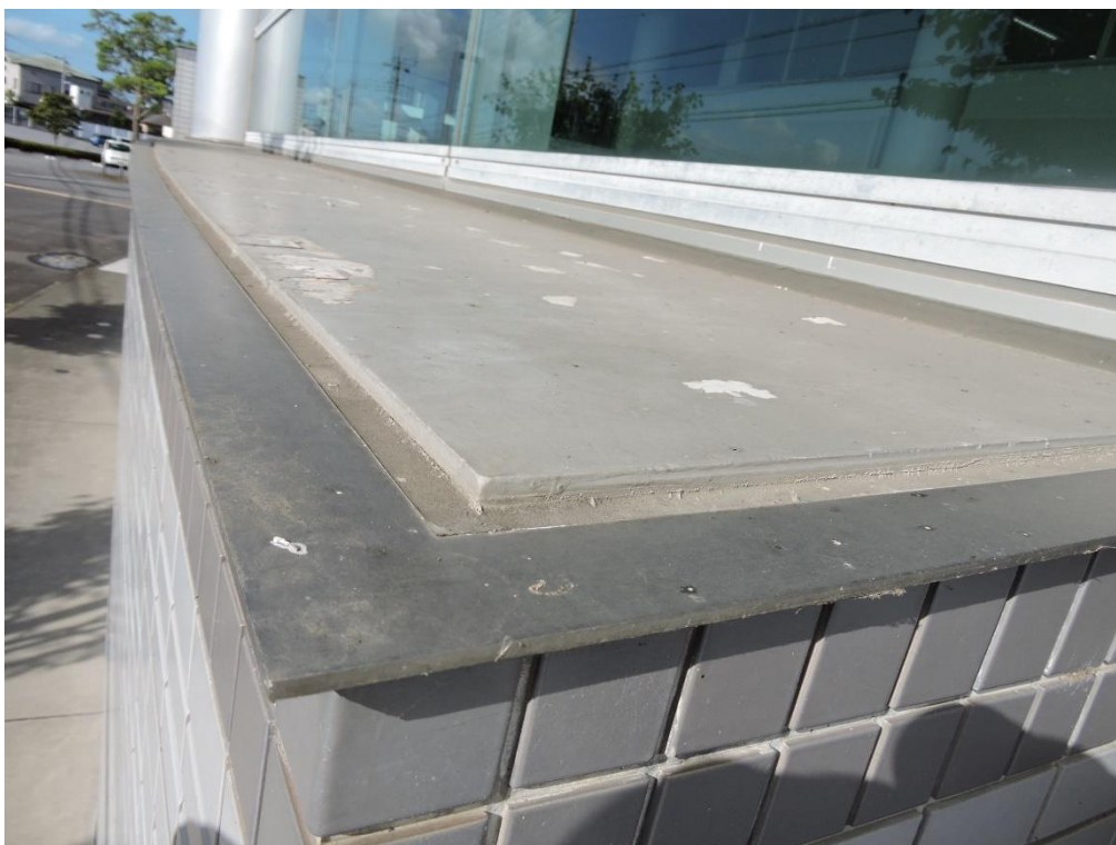
ステンレス見切取合部分シーリング工事（一部抜粋）
