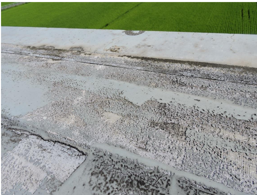
平場・立上り部分防水工事
