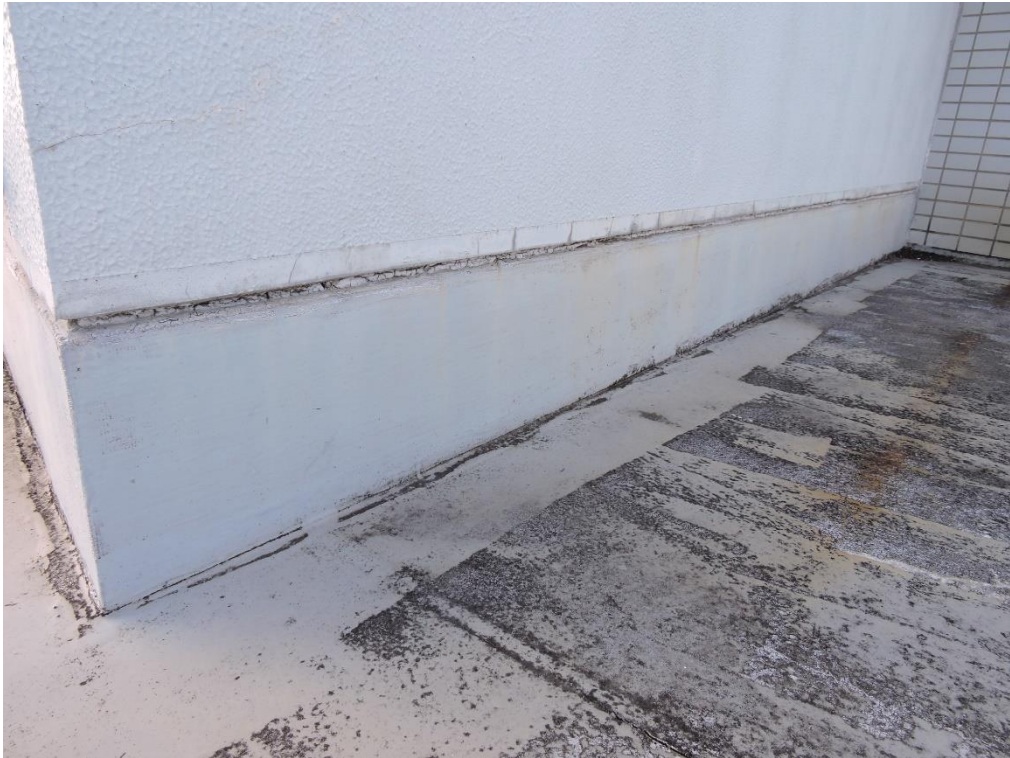
平場・立上り部分防水工事
