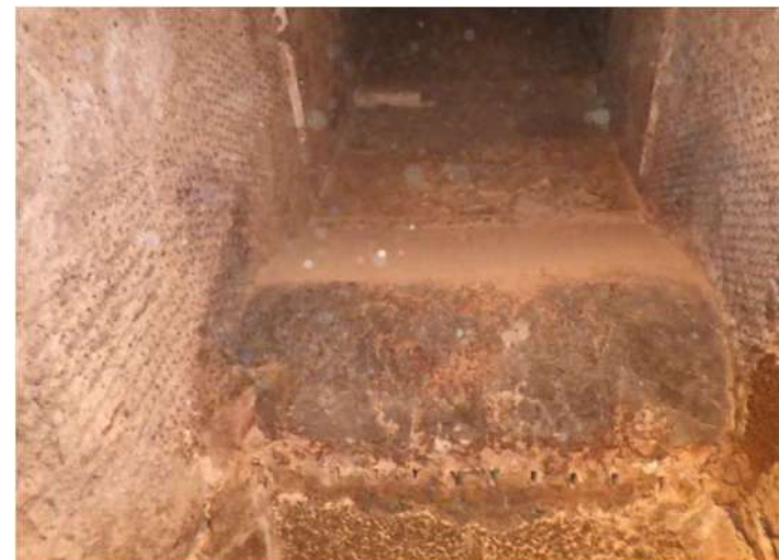
ボイラ耐火物(炉内) 施工後
