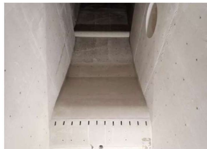
ボイラ耐火物(炉内) 施工後
