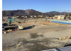
杭工事施工前
