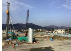
杭工事施工中
