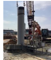
既製杭打設状況
