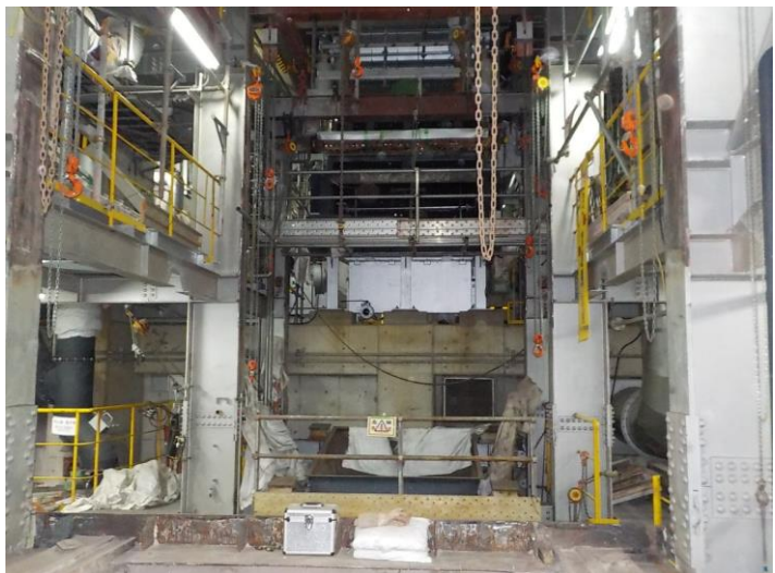
燃焼設備解体後
