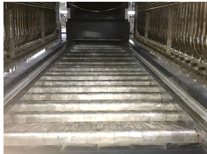
燃焼設備据付中
