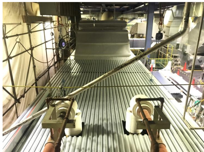
ボイラ据付中
