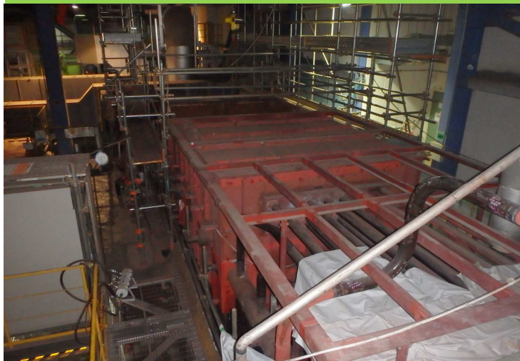
ボイラ据え付け
