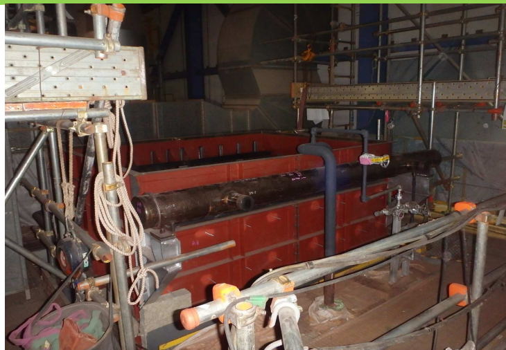
節炭器据え付け
