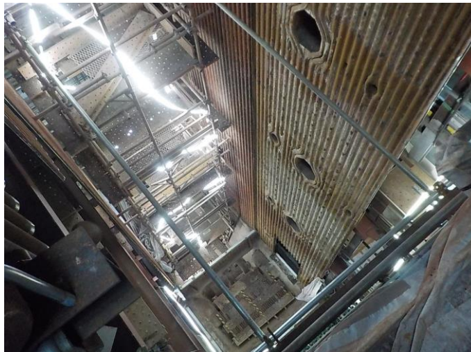
ボイラ（3パス）解体
