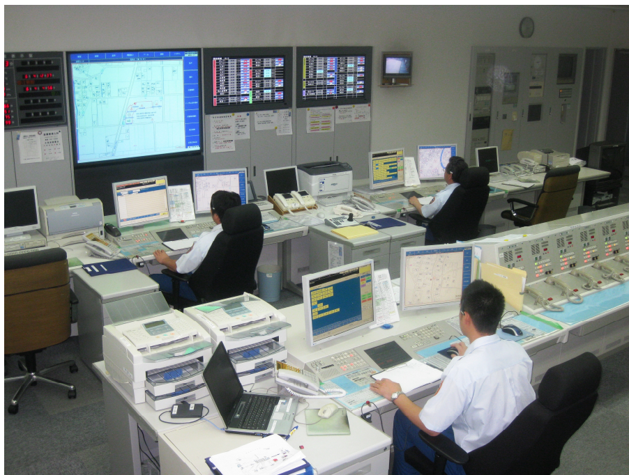
（消防本部通信指令室）
