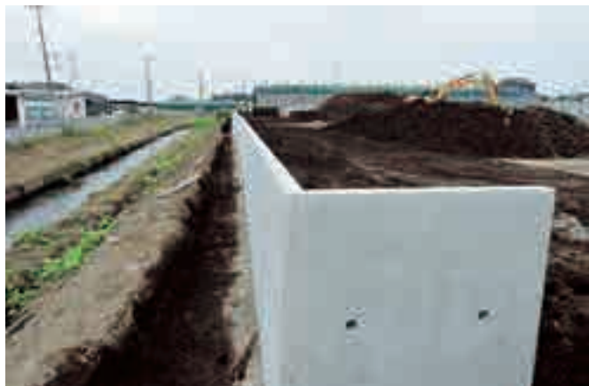
江連用水との境界に設置したL型擁壁
