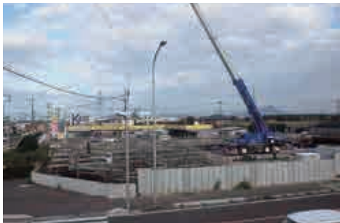
建物基礎工事の状況
