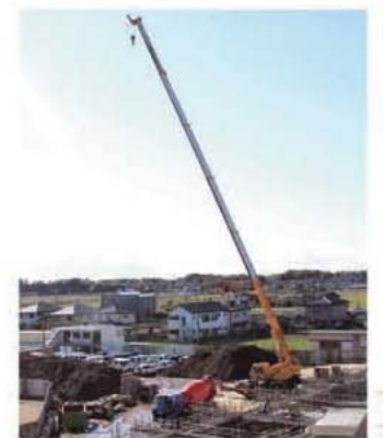
新校舎建設中
