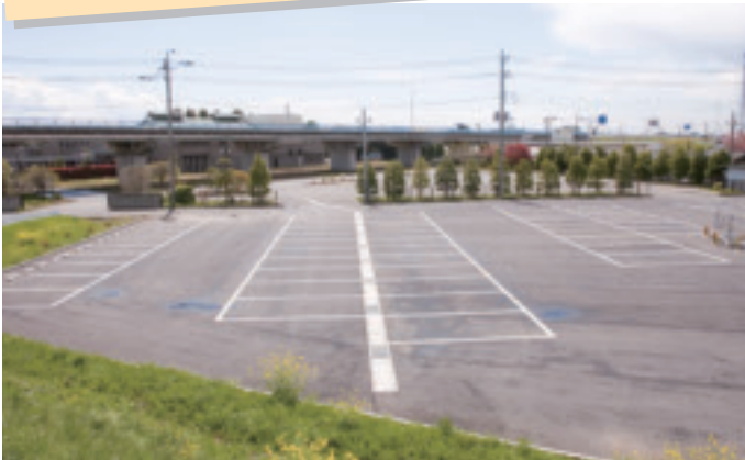
熔融スラグを利用したアスファルト舗装材は、「きぬ聖苑」の駐車場にも使用されています
