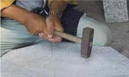
びしゃん仕上げ 叩く面がギザギザした金槌で表面を仕上げる
